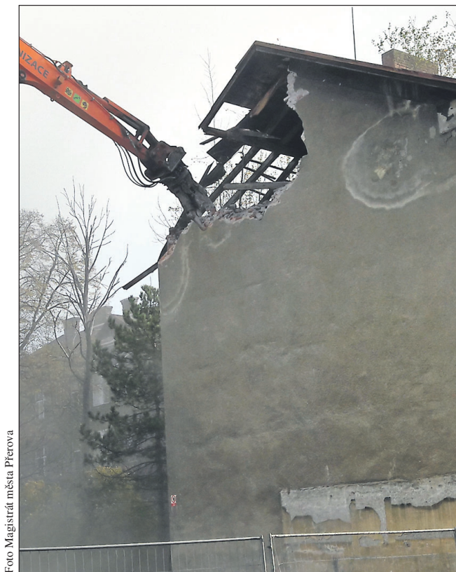
Bourání domů začalo ve Škodově ulici loni na konci října.
